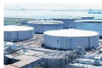
石油貯蔵タンク
